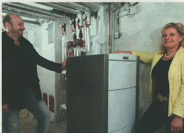
Familie Jauk aus Arnfels heizt bereits nächsten Winter mit einer neuen Öl-Brennwertanlage um 5.000 Euro. Foto: IWO
