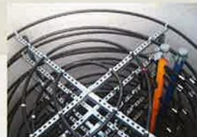
Entzugs- und Regenerationswärmetauscher im Primärquellenspeicher mit 10 m<sup>3</sup> Wassergehalt. Das Wasser dient als Speichermedium und wird im Bedarfsfall kontrolliert vereist.
